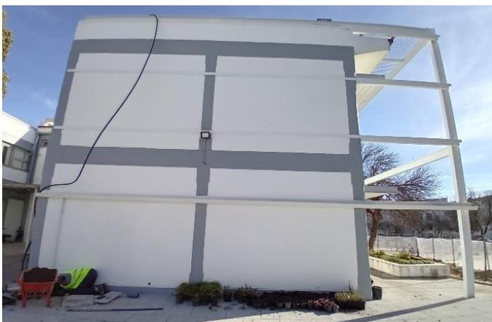
Figura 28 Fachada poente. Instalação de estrutura metálica de suporte do protótipo mBIGToldo.
