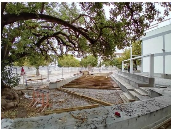
*Figura 31 Pavimento exterior permeável. Instalação de estrado de madeira suspenso.*
