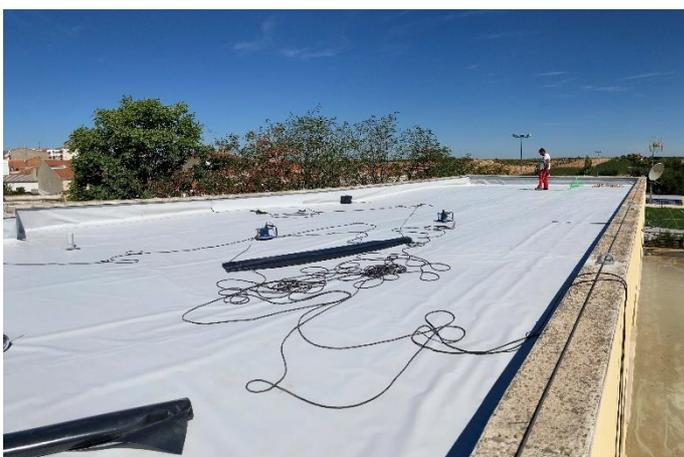
*Figura 1 Aplicação de impermeabilização em película de PVC.*
