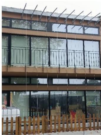
*Figura 41 Estrutura de cabos de aço.*
