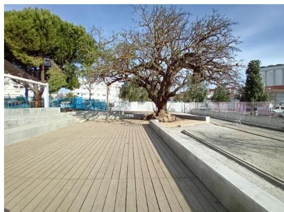
*Figura 32 Pavimento exterior permeável. Estrado de madeira suspenso.*
