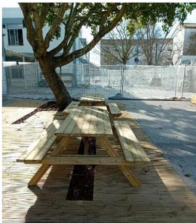
Figura 33 Pavimento exterior permeável. Estrado de madeira suspenso.
