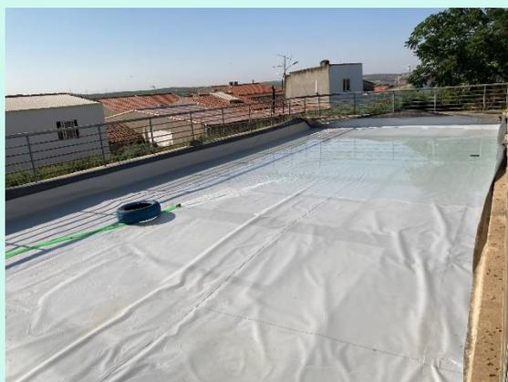
*Figura 15 Teste da impermeabilização por inundação.*
