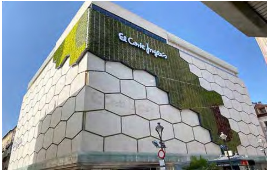
Figure 7. Green facade at El Corte Inglés in Valladolid (Source: Valladolid City Hall).
