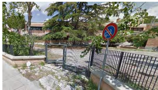
Southeast façade (Istituto di Istruzione Secondaria di primo grado G. Galilei, Grosseto, ITALY).
