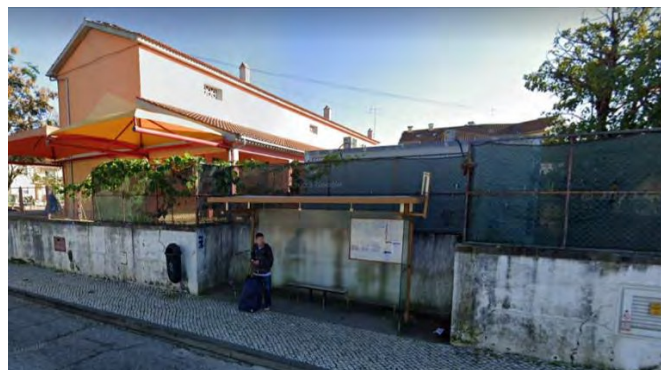
West façade (Escola Básica 1 de São Martinho do Bispo, Coimbra, PORTUGAL).
