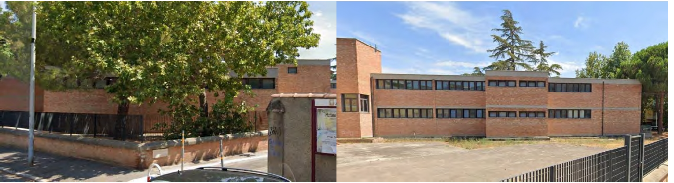
Northwest façade (Istituto di Istruzione Secondaria di primo grado G. Galilei, Grosseto, ITALY).
