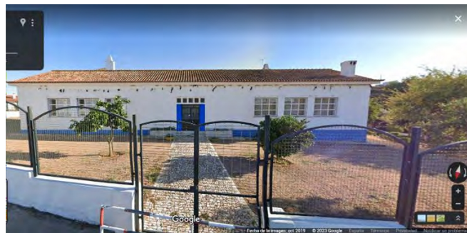
North façade (CEB Rio Moinhos, Abrantes, Portugal).
