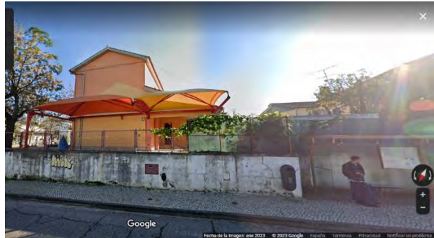
North façade (Escola Básica 1 de São Martinho do Bispo, Coimbra, PORTUGAL).
