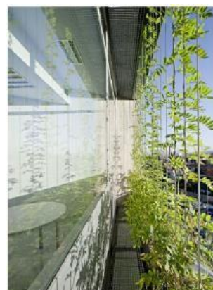
Esquema em corte transversal da composição do protótipo mBiGFAC. Exemplo de uma fachada verde com cabos.
