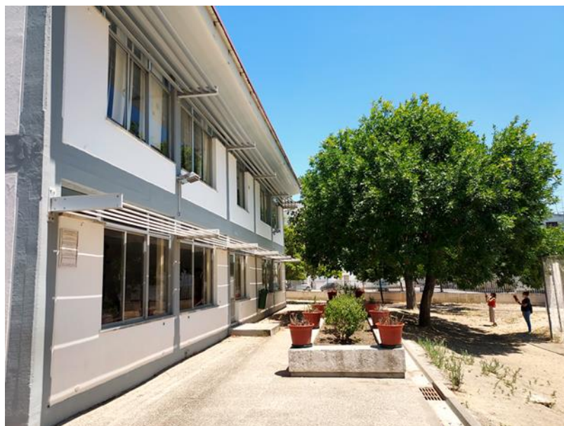
Figura 10. Imagen de la fachada sur del colegio.
