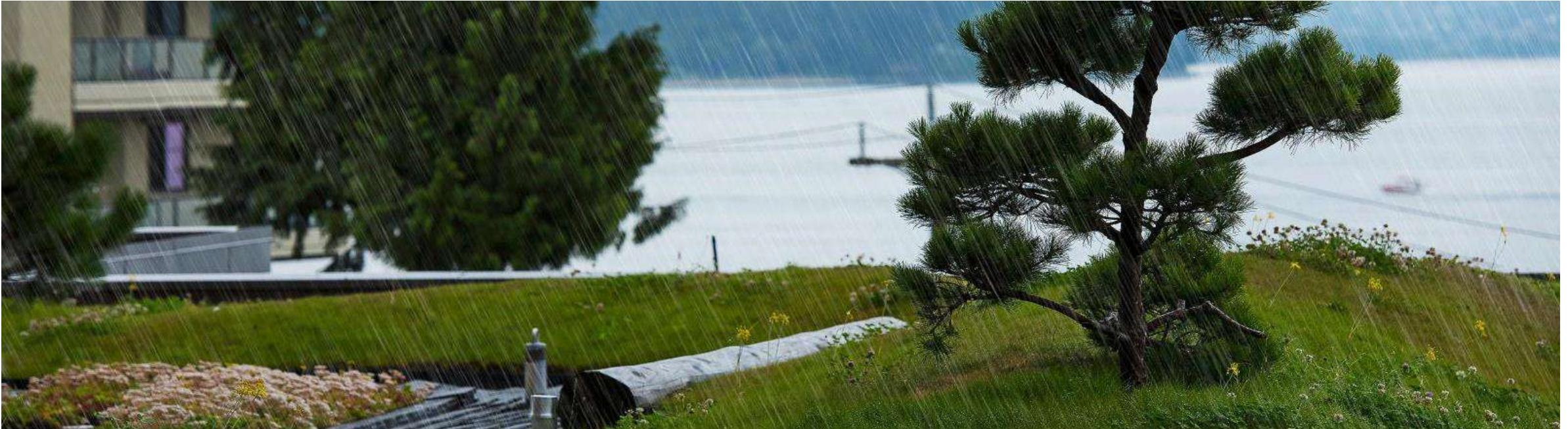
Aumento de retenção de água na cobertura verde → Atraso da chegada da água ao sistema de drenagem urbano
