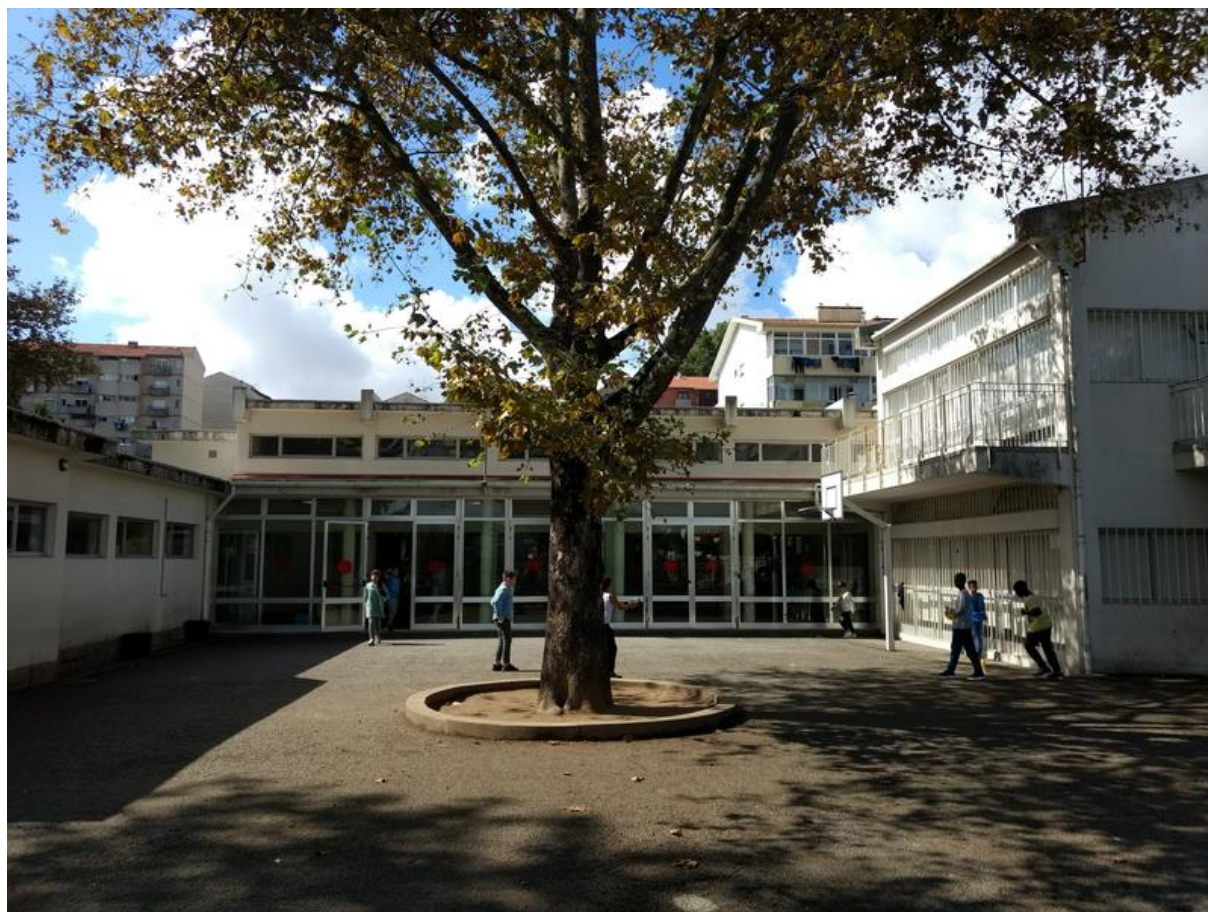
Figura 10. Zona exterior delante de la fachada sur F2.
